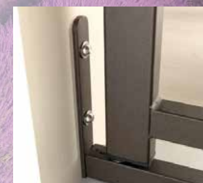
Dettaglio del sistema di fissaggio a muro
